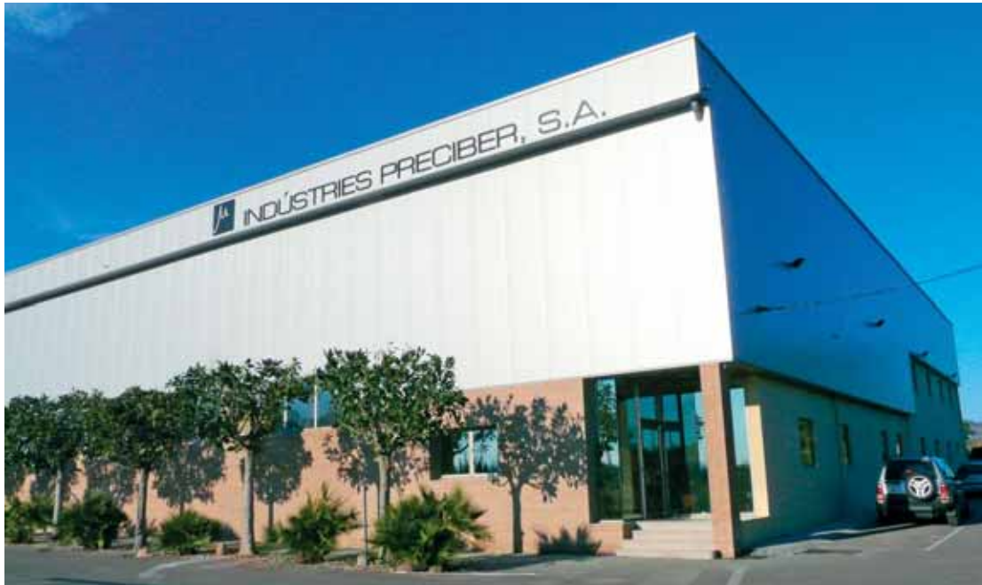
Die modernen Betriebsgebäude von Preciber, nach den in 2009 erfolgten Erweiterung.
