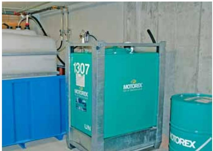
Das zentrale Bearbeitungs-Fluid-Lager im Untergeschoss senkt den Logistik-Aufwand deutlich. Lieferungen und Abtransporte können rationell und nach den geltenden Sicherheits- und Umweltnormen durchgeführt werden.
