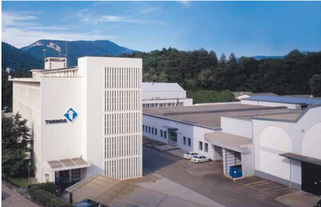
Tornos 2007, vor dem Bau des neuen Gebäudes.
