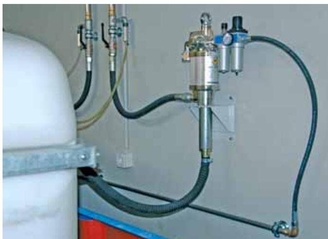
Des pompes pneumatiques haute performance alimentent la colonne d'alimentation en fluide de la station de distribution centralisée dans la salle des machines. Grâce à l'huile de coupe MOTOREX ORTHO NF-X universelle, la gestion des fluides a pu être considérablement simplifiée.
