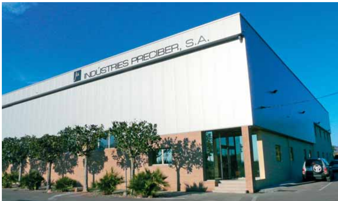
Les locaux modernes de Preciber à la fin de l'agrandissement de 2009!
