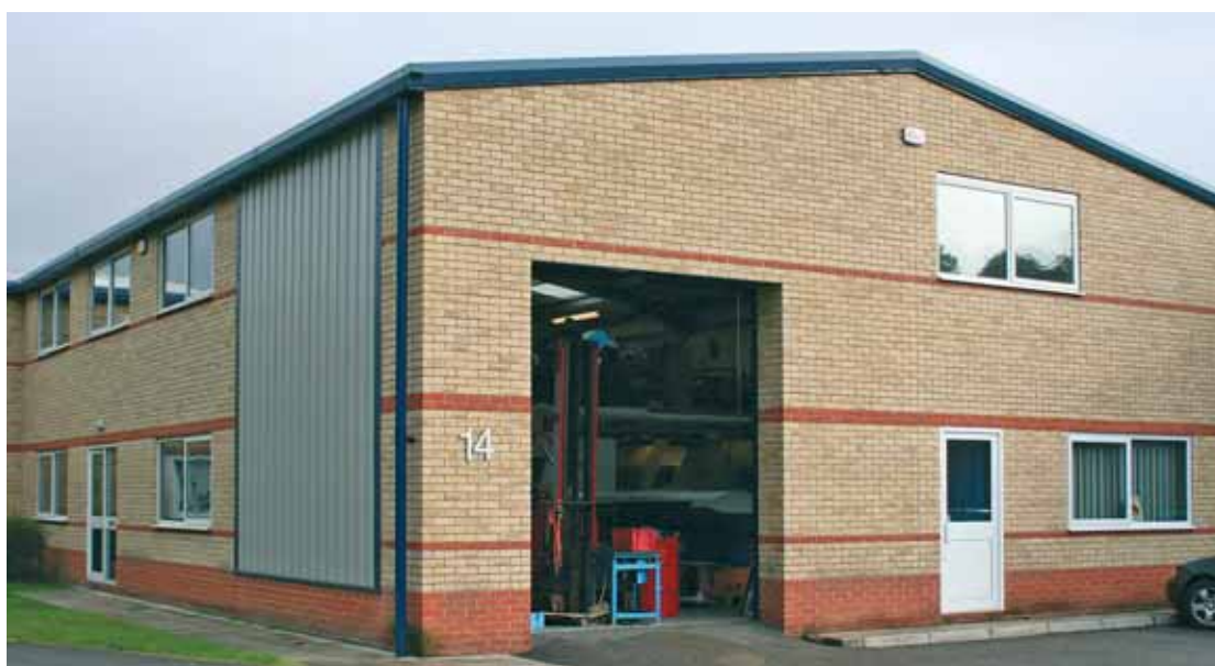
Les locaux de APB à Sandhurst, Berkshire (Royaume-Uni).
