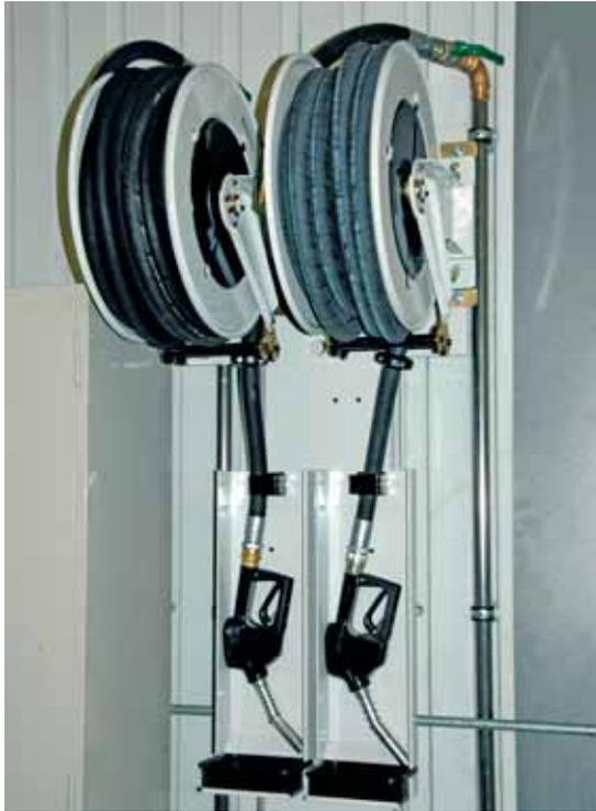
Il riempimento dei serbatoi d'alimentazione può essere centralizzato ed in prossimità delle macchine servendosi di srotolatori murali per tubi flessibili. Un indicatore di livello, posto sul serbatoio, e un dispositivo di interruzione automatica impediscono qualsivoglia eccesso di riempimento.
