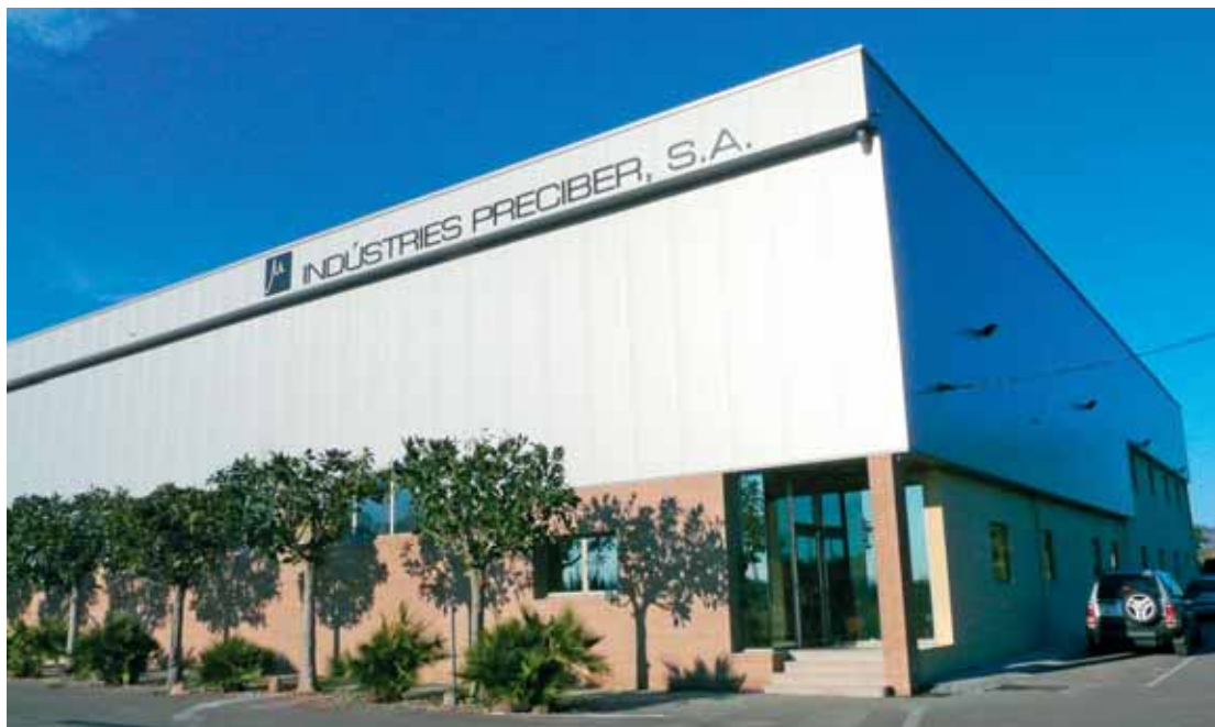
I moderni locali Preciber dopo l'ampliamento conclusosi all'inizio del 2009.
