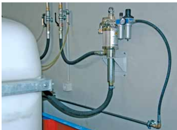
Effektiva pneumatiska pumpar levererar vätsketillförseln vid den centrala utmatningsstationen i maskinrummet. Tack vare den universellt användbara bearbetningsoljan MOTOREX ORTHO NF-X har det varit möjligt att förenkla vätskehanteringsprocessen betydligt.
