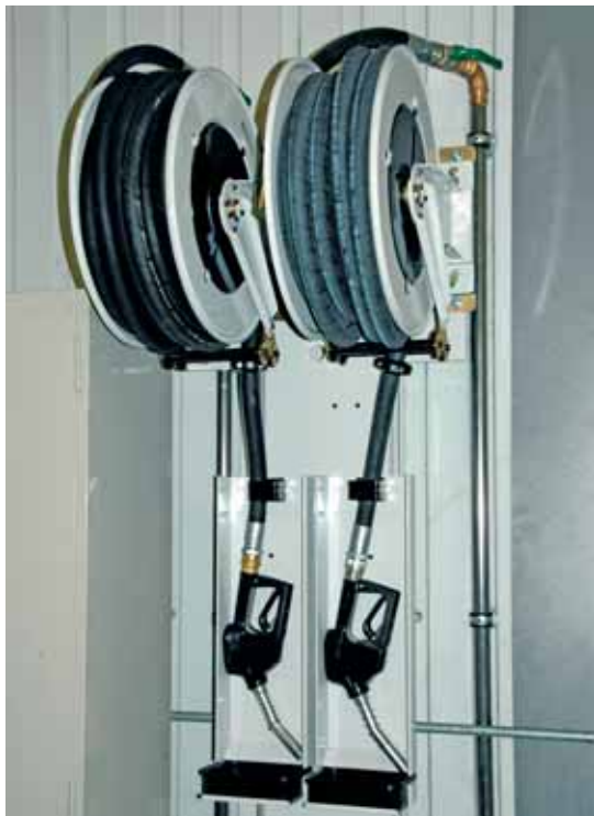
Med de väggmonterade slangrullarna kan tillförselbehållarna fyllas centralt och i närhet till maskinerna. En nivådisplay på behållaren och en automatisk avstängningsenhet skyddar systemet från att överfyllas.
