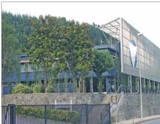
Microdecos fasad och den harmoniska integreringen av olika byggnader. Från utsidan, en grön teknisk miljö.
