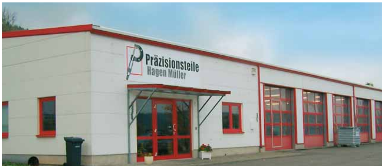
Endast bebodd sedan september 2007 och redan proppfull: den nya byggnaden hos Müller Präzisionsteile.
