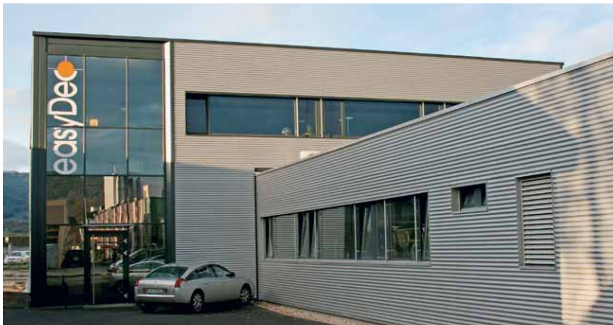
Les machines, réparties sur deux étages, fonctionnent 24h/24 dans les locaux ultra-modernes de l'entreprise récemment construits à Delémont.
